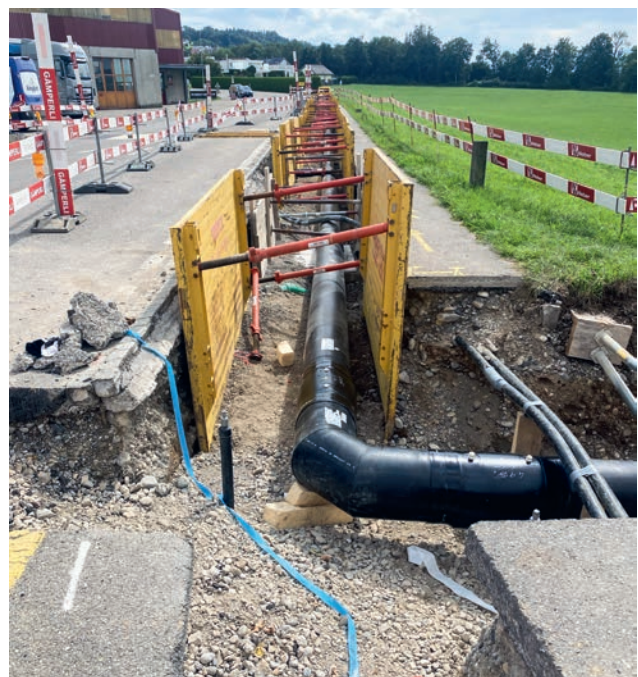
Die Fernwärmeleitung kommt unter den Radweg zu liegen.
