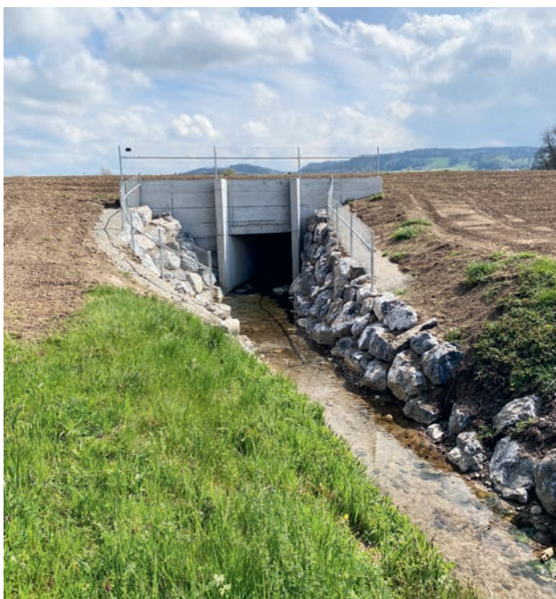
Das fertiggestellte Hochwasserrückhaltebecken.
