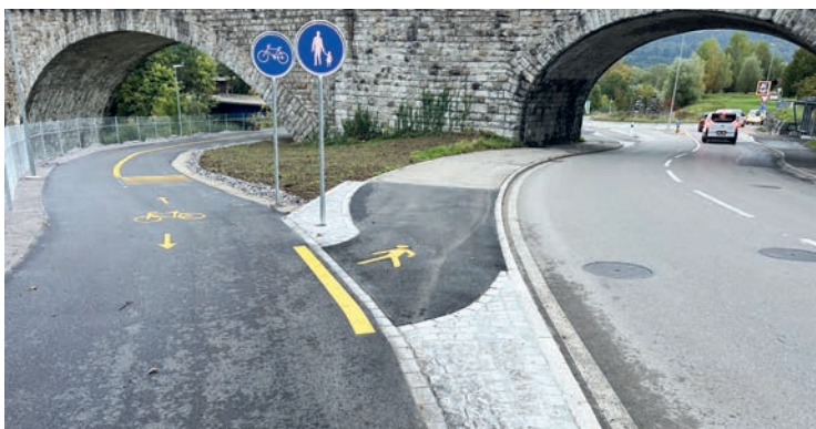
Der Radweg verläuft neu links vom Brückenpfeiler.
