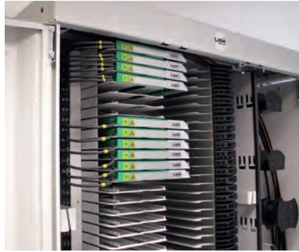
*In den Kassetten werden die einzelnen Fasern aufgeschlüsselt*
