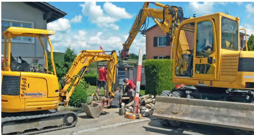
*Voller Einsatz von Maschinen und Menpower für den Ersatz eines Stromverteilkastens bei der Sonnhalde*
