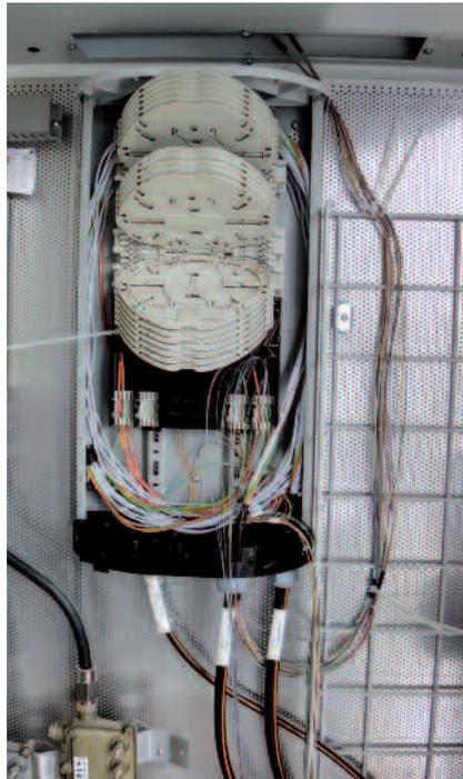
*Diverse Glasfaserkabel werden für die Installation vorbereitet*
