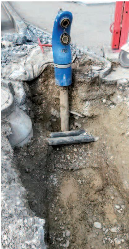
*Ersetzen eines komplett neuen Hydranten*
