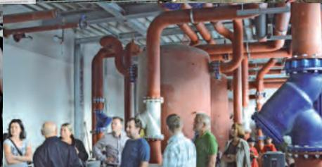
*Bild links: Besichtigung der Heizzentrale: Pufferspeicher für die Erdwärmeanlage*
