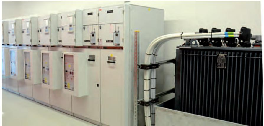
*Innenleben einer Trafostation mit der Mittelspannungszuleitung zum Trafo und den Abgangsfeldern. Alles berührungssicher erstellt*
