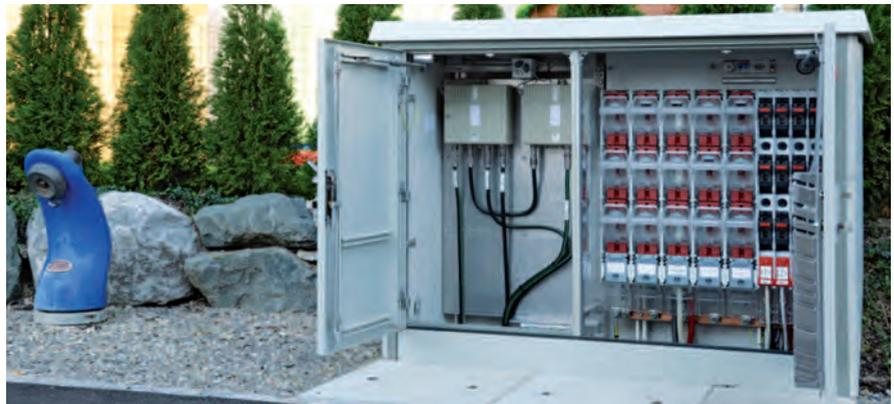
*Blick in eine Verteilkabine. Linker Teil: Verstärker und Hausabgänge TV, Internet, Telefonie. Rechter Teil: Niederspannungsseite Strom, Abgänge für Hauszuleitungen mit Sicherungen*
