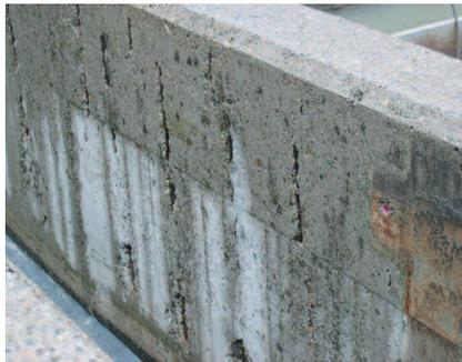
Die alten Becken wiesen Korrosionsschäden auf
