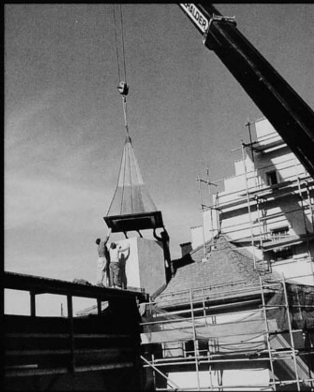
In der ganzen Schlossanlage wurden die inneren Wände abisoliert, die alten Sandsteinfenstergewände und Holzfutter ersetzt und der gesamte Fassadenverputz erneuert, die Fenster nach denkmalpflegerischen Vorschriften in Dreifach-Verglasung mit Sprossenunterteilung neu eingebaut, sowie alle Dachstühle erneuert und die Dächer mit speziellen Biberschwanzziegeln neu eingedeckt.
