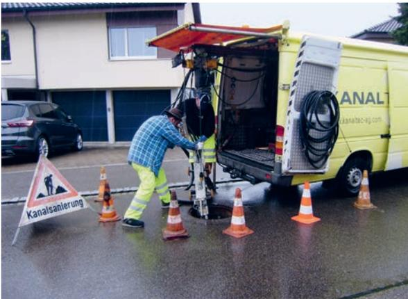
Robotereinsatz bei Kanalsanierungen
